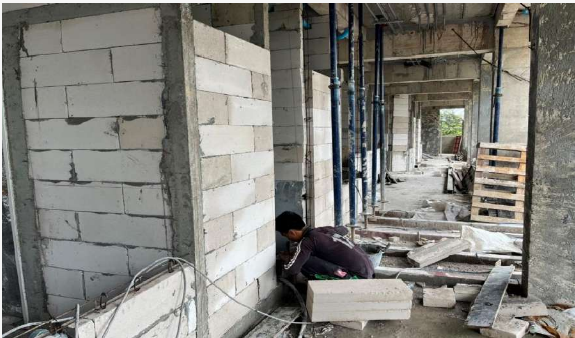
รูปภาพงานก่อผนัง ชั้นที่ 3
