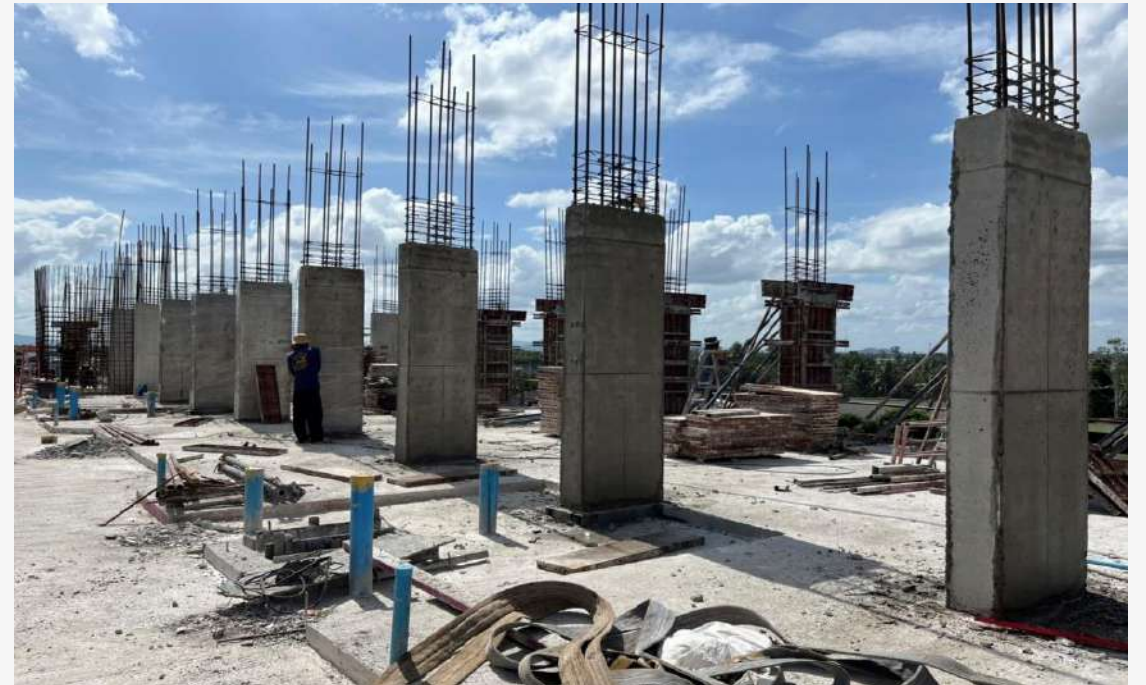
รูปภาพงานเสาชั้นที่ 6
