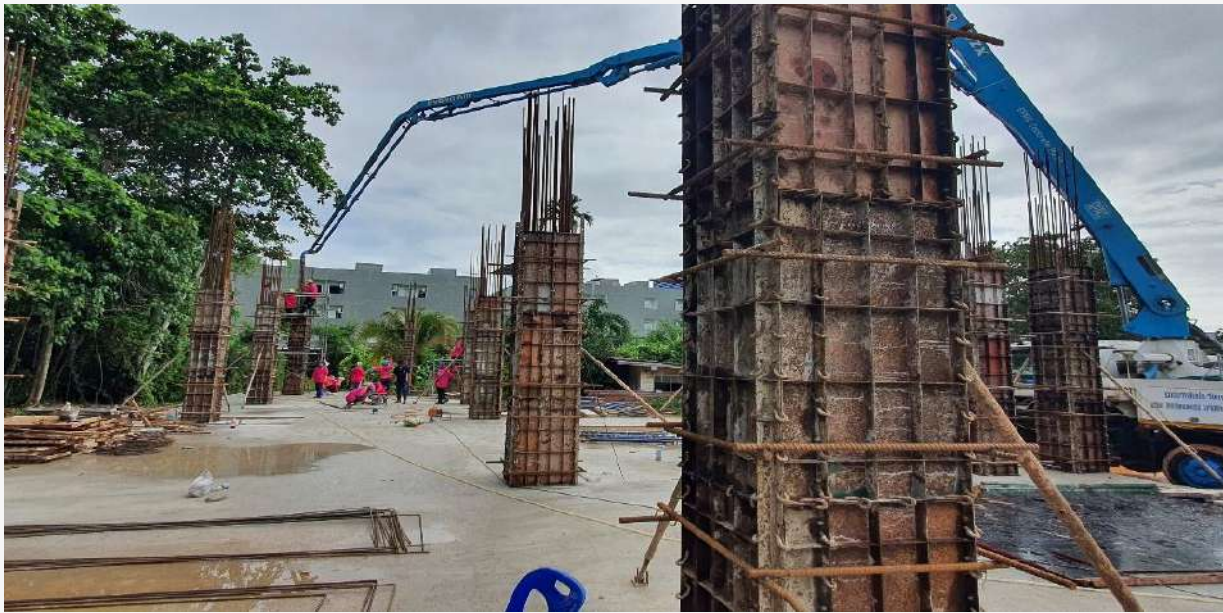
รูปภาพงานเทเสาชั้นที่ 1
