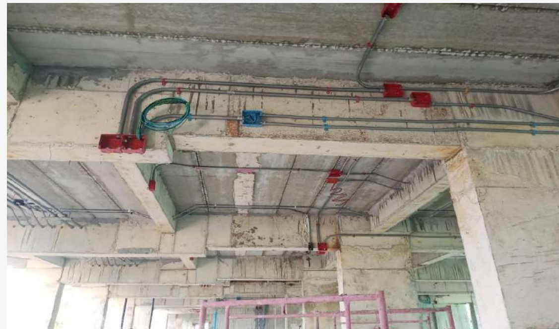
รูปภาพงานเดินระบบไฟฟ้าภายในอาคาร
