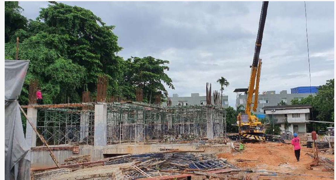
รูปภาพงานปัจจุบัน งานคาน, พื้นชั้นที่ 2
